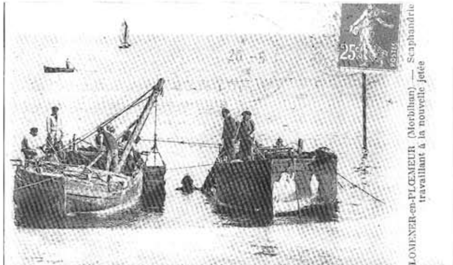
Scaphandriers travaillant à la construction de la nouvelle jetée de Lomenier-1924-
